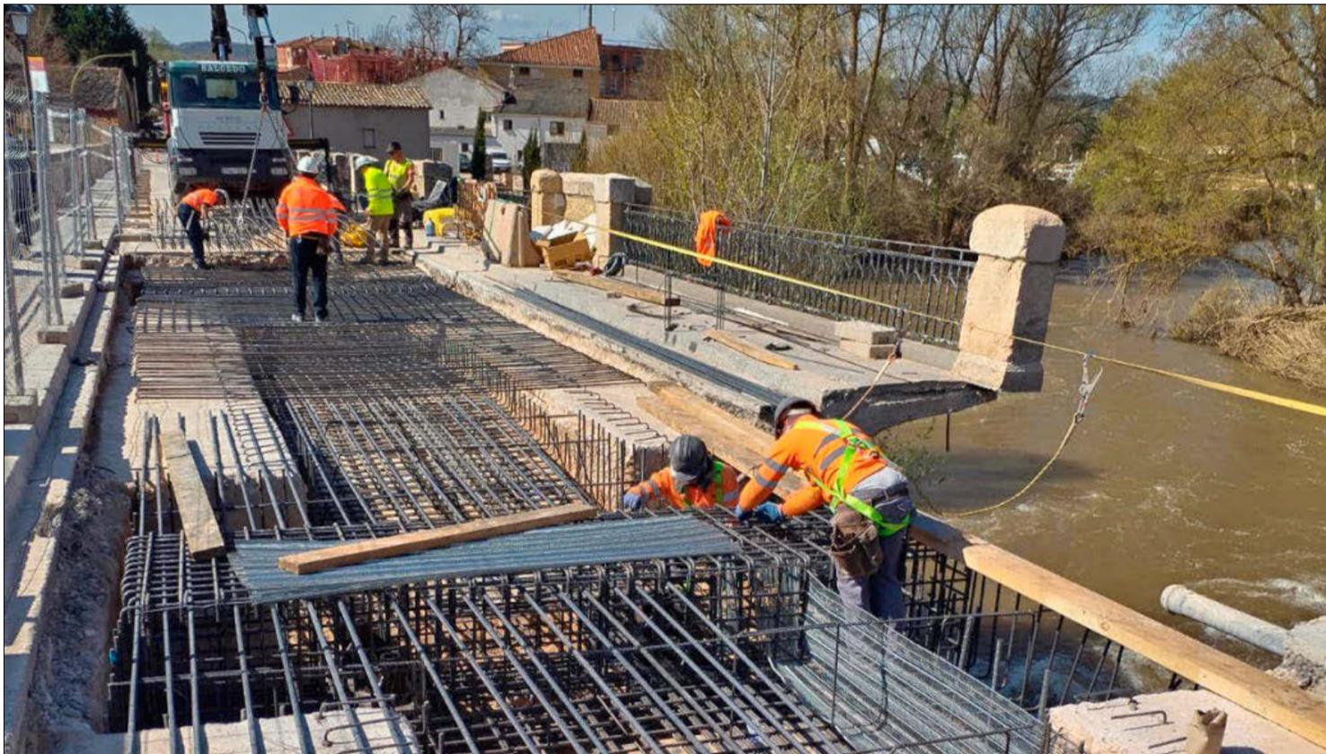
Ya se han ejecutado los micropilotes de refuerzo de la estructura en el puente medieval de San Esteban de Gormaz. HDS
